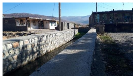
شکل ۲. کانال سنگ و ملاتی موجود
